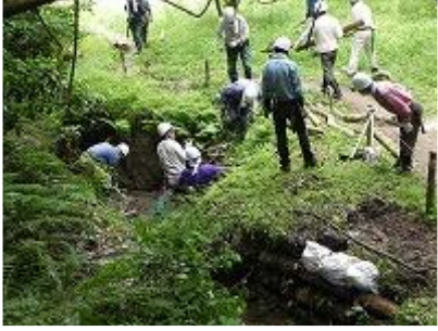
土壘5か所目作業中
