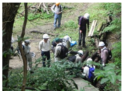
予定外の土手の補修作業
