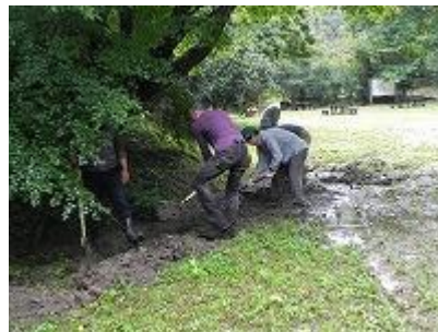
土砂の流れ込み防止に溝掘
