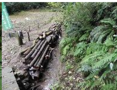
護岸作業完了
