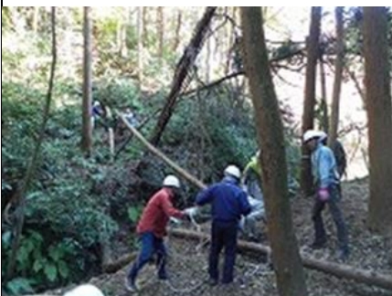
対岸での作業
