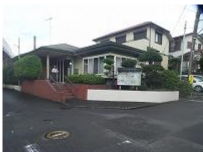
作業前の会館
