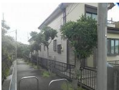
上の通路 作業前
