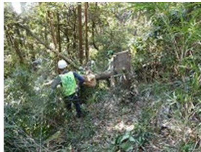
斜面での作業
