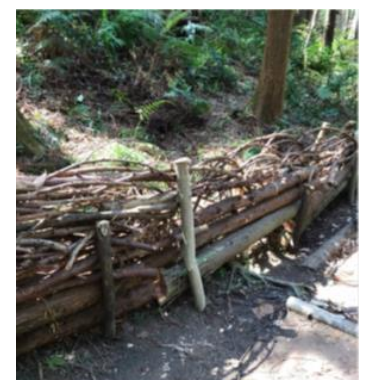
製作した防護柵
