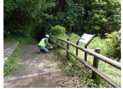
道路、柵沿いで作業中
