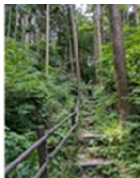
中尾根・作業前
